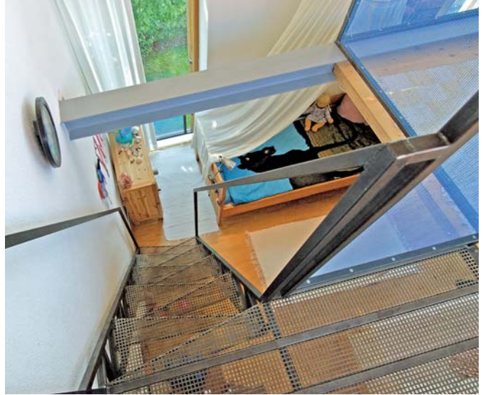
Im Kinderzimmer muss nicht alles niedlich sein: Stahlträger, Holzdecke, gläserne Brüstung.
