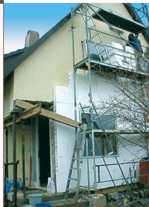
Der Altbau von 1956 wurde mit einem Wärmedämm-Verbandsystem auf zeitgemäßen Standard gebracht.
